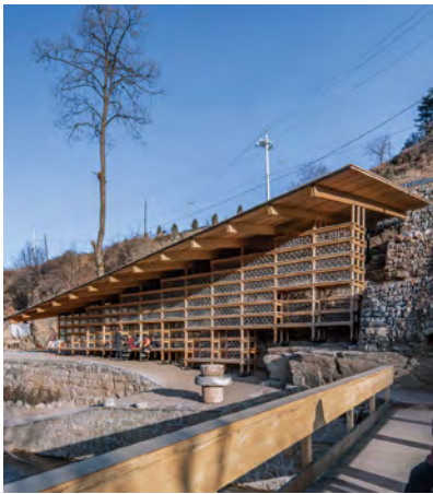
▲ 浙水村位于山西省太行山脉，建筑与山水密不可分。许多房屋直接建在山体之中，浙水自然图书馆延续了这一传统，依山而建，与周围的自然环境融为一体
