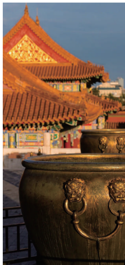
▲明清两代，宫中建筑周围都安置有盛水的铜、铁缸，称作“太平缸”，用于防范火灾。清代时宫中规定，每年小雪至次年惊蛰期间要“熏缸化冰”。太监们给铜缸裹上棉套、盖上盖子，再根据气候冷暖在院中的太平缸底部煤炭，以防缸中水结成冰耽误了救火。
